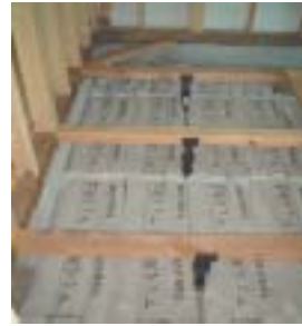
床下への敷き詰め Aタイプ
