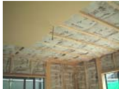
天井面への施工 Bタイプ（断熱材併用）
