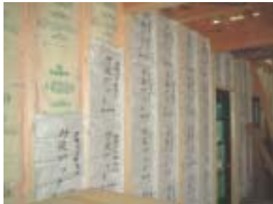
壁面への施工 Bタイプ（断熱材併用）
