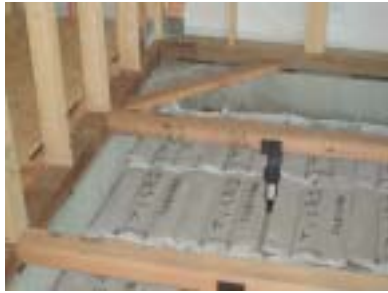
床下への敷き詰め Aタイプ
