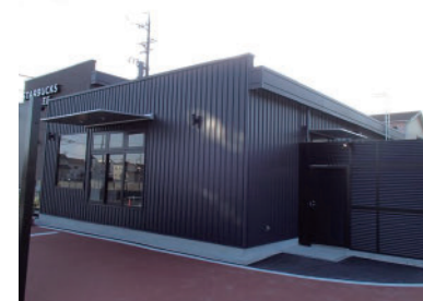
外壁材にも使用した事例
